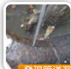
發現管道漏水
