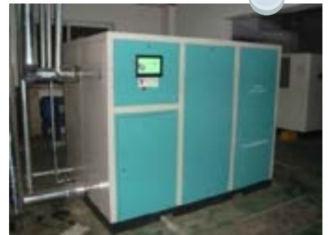
◆ 餘熱回收主機
